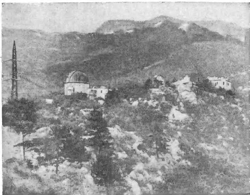
Фиг. 1. Общий вид Обсерватории в Симнеизе. Слева видна башня, в которой ранее находился рефлектор с зеркалом в 1 м; сейчас в ней расположена солнечная установка. Около башни виден павильон спектрогелиоскопа. В двух башнях в средней части снимка находятся астрографы. Маленькая белая башня — верхняя часть небулярного спектрографа. Справа видно главное здание Обсерватории.
