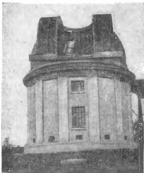
Фиг. 4. Законченная башня двойного 400-миллиметрового астрографа. В отверстии люка виден телескоп.
